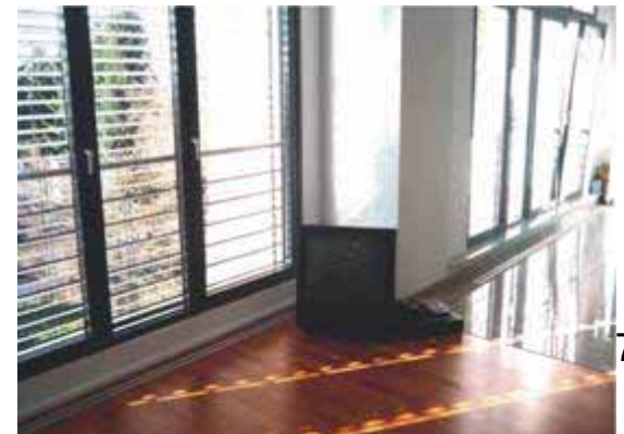
verlegter Oberboden Wohnen / Luftauslass-Schlitzschiene
