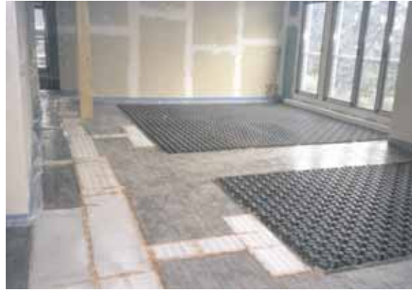
Verlegte proKLIMA Systemfläche
