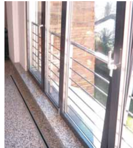
verlegter Oberboden Küche mit Schlitzschiene
