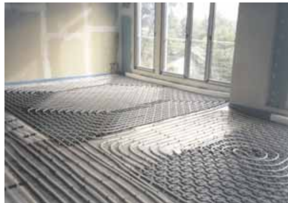
proKLIMA Systemfläche mit Heiz-/Kühlrohr vor Estricheinbringung
