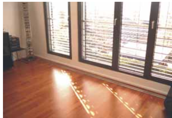
verlegter Oberboden Wohnen mit Luftauslass-Schlitzschiene
