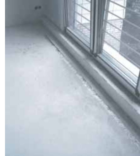
Luftauslass-Öffnungen nach Estricheinbringung
